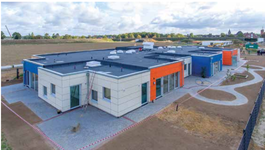
Abb. 2: Die Kita „An der Niers-Aue“ in der Stadt Korschenbroich wurde in moderner Holzbauweise errichtet
